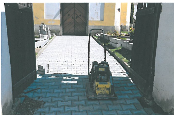
Oprava chodníku u kostela v Malých Heralticích
