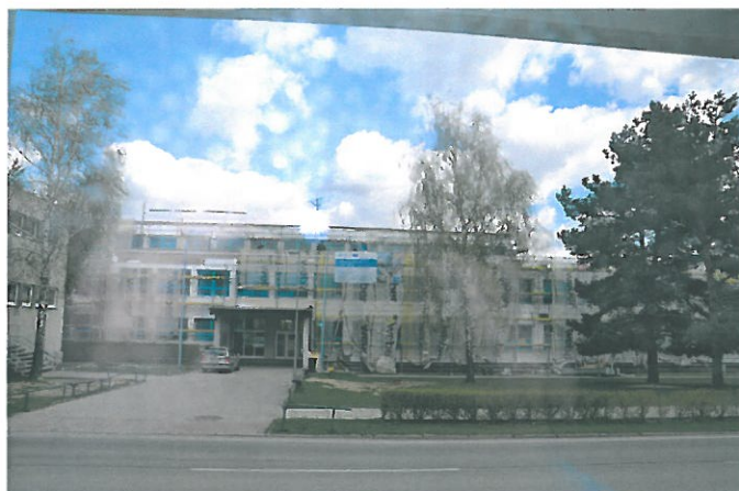
Zateplení ZŠ a družiny ve Velkých Heralticích
