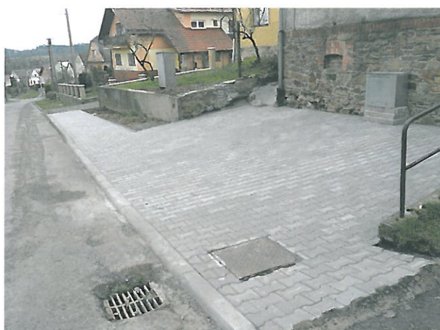
Oprava chodníku v Sádce
